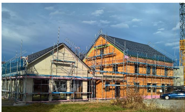
Aktueller Stand der Baustelle Rathaus vom Dezember 2017
